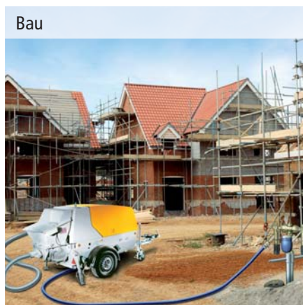
Bereitstellung einer Bauwasserversorgung
